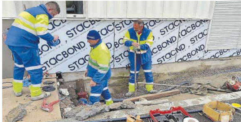
Operarios de Aqualia, trabajando en una conexión en Moaña.
